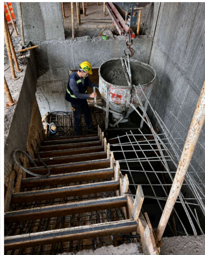
Cargamento de pilares N6 – N7 – Cargamento de pilares N7 – N8 – Cargamento de escalera SS1-PB
