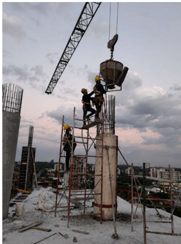
Cargamento de pilares N6 – N7 – Cargamento de pilares N7 – N8 – Cargamento de escalera SS1-PB
