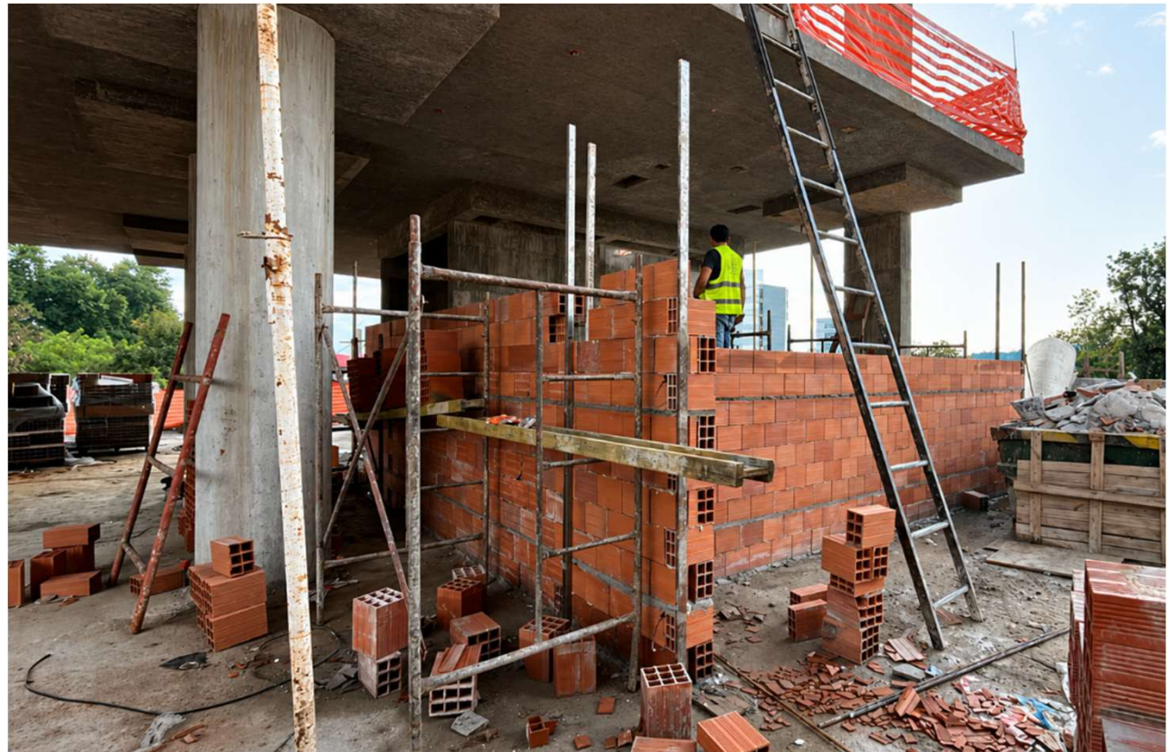
Avance de replanteo N1 – Elevación de mampostería en N1
